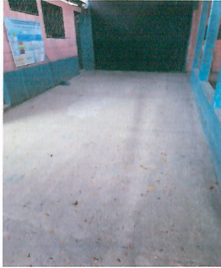
Foto 1: LOSA DE PATIO FRENTE A LAS UALAS Y BODEGA
