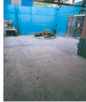
Foto 2: LOSA DE PATIO FRENTE A LA ENTRADA DE LA ESCUELA
