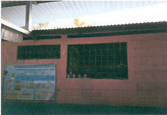
Foto 3: VENTANALES EN EL AREA DE BODEGA
