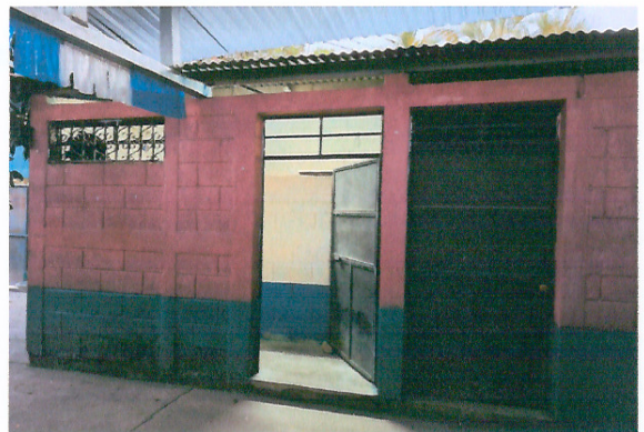
Foto 4: VENTANALES EN EL AREA DE BAÑOS
