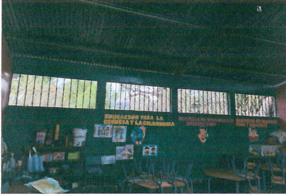
Foto 1: VENTANALES POR DENTRO DEL AULA
